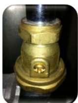
Avstängningsventil Stängt läge.
